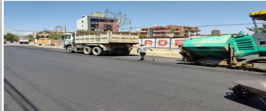
FOTO 2. CONST. PAVIMENTO ZONA SUDESTE DISTRITO 1 (OTB MIRAFLORES SUD)
