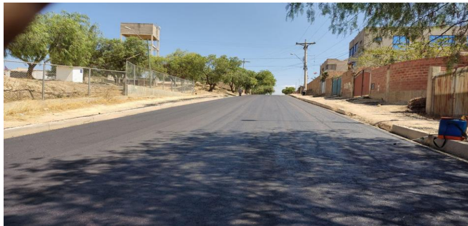
FOTO 3. CONST. PAVIMENTO ZONA SUDESTE DISTRITO 1 (OTB SAN PEDRO)
