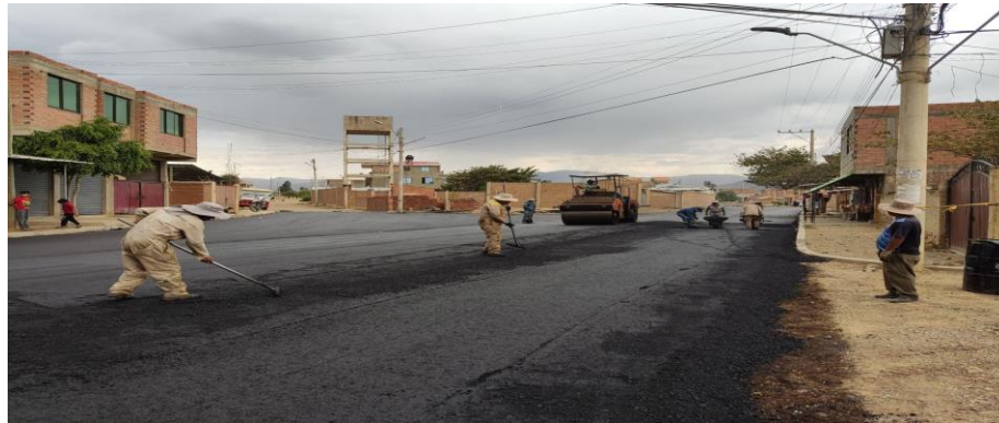
FOTO 1. CONST. PAVIMENTO DISTRITO 7 (OTB VILLA ANTOFAGASTA - PUEBLITO)
