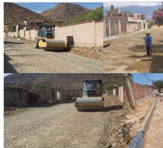
CONST. EMPEDRADOS Y CORDONES DISTRITO 6 (OTB CAPILLA NORTE, OTB ABRA CENTRAL Y OTB LA VIÑA)
