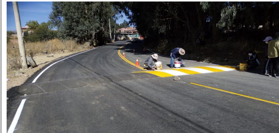
FOTO 4. CONST. PAVIMENTO AV. MONS. ALCOCER ZONA NORTE DISTRITO 1
